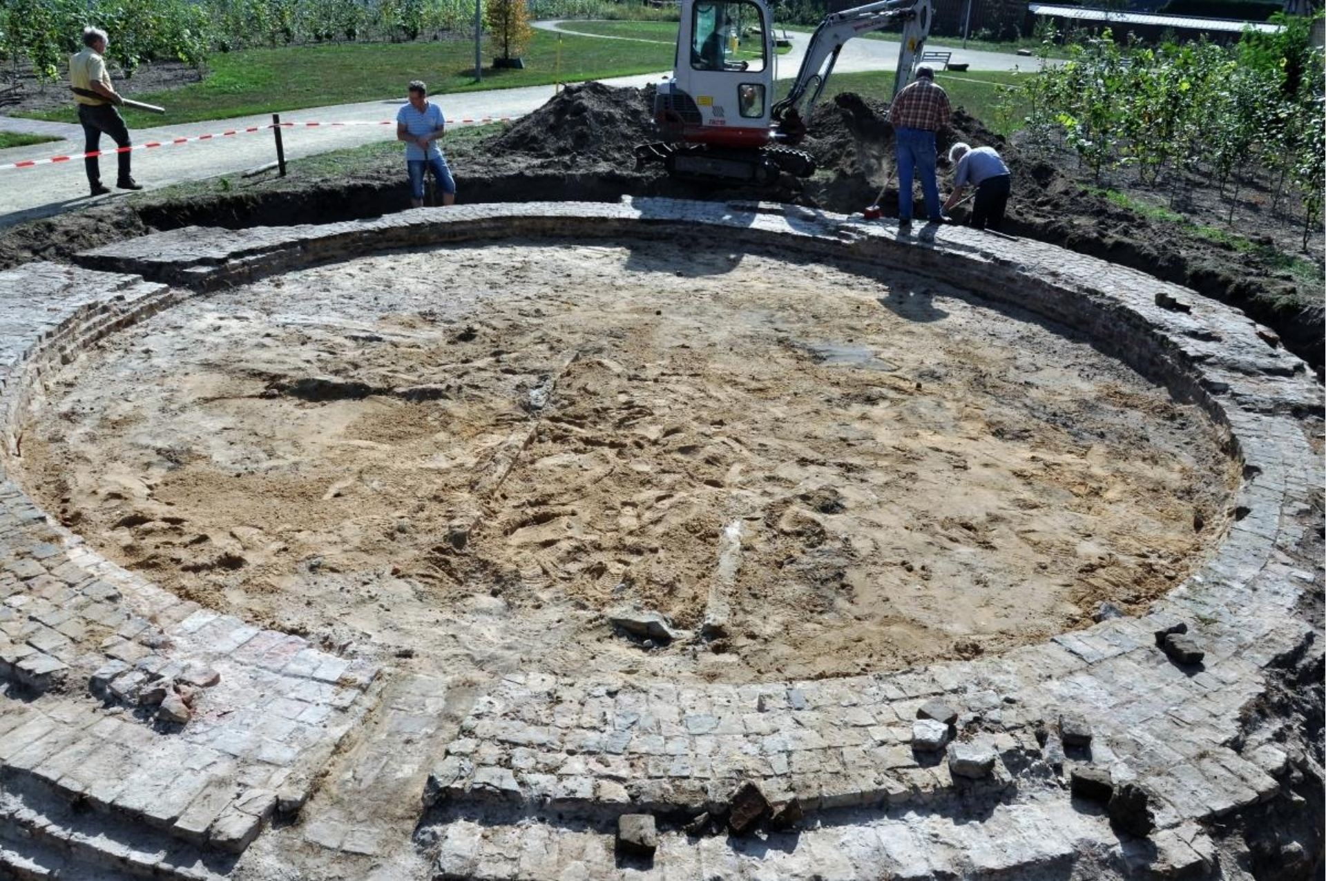
Fundament molen De Nijverheid (1897) te Erp (Meierijstad), herontdekt na sloop mengvoederbedrijf.
